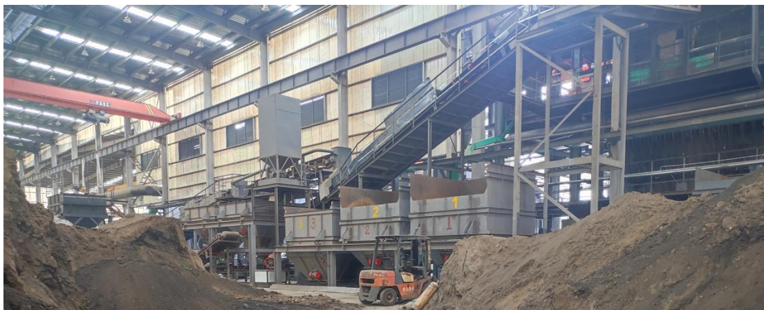
图 4.1-4 皮带运输现场图片
