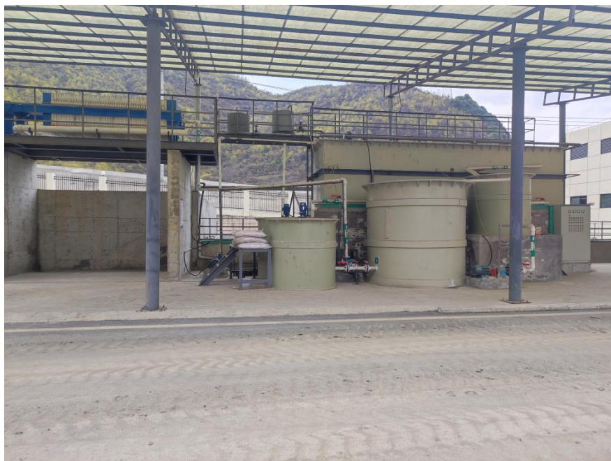
图 4.1-3 污水处理站现场图片
